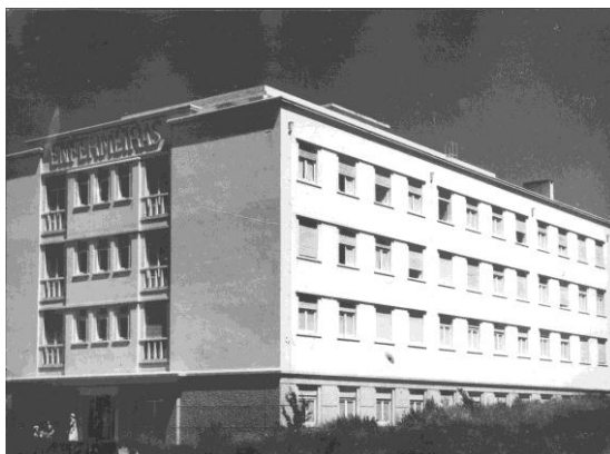
Fotografia nº 2 – ETE – Edifício da Escola/Residência-Internato (1944)
